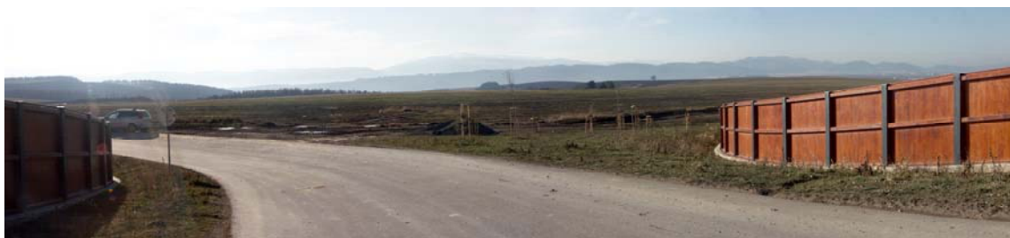
Obr. 5: Ekologický most na dálnici D1 v úseku Mengusovce - Jánovce: panoramatický pohled na stranu přecházející do volné přírody (foto autor)
