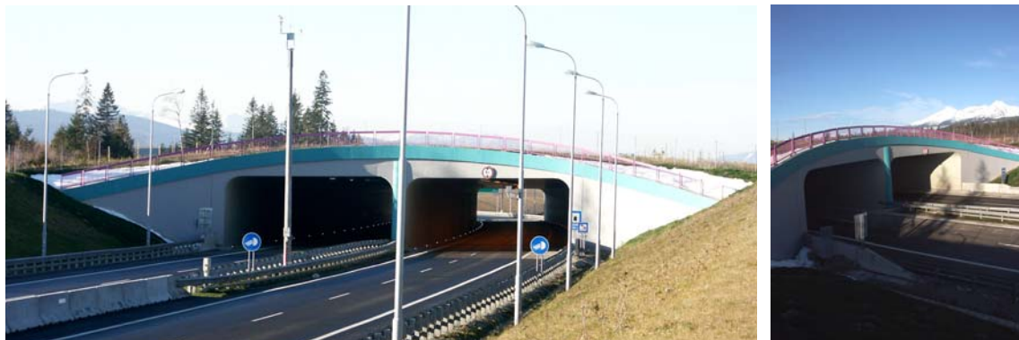
Obr. 7: Ekologický tunel na dálnici D1 v úseku Važec - Mengusovce (foto autor)
