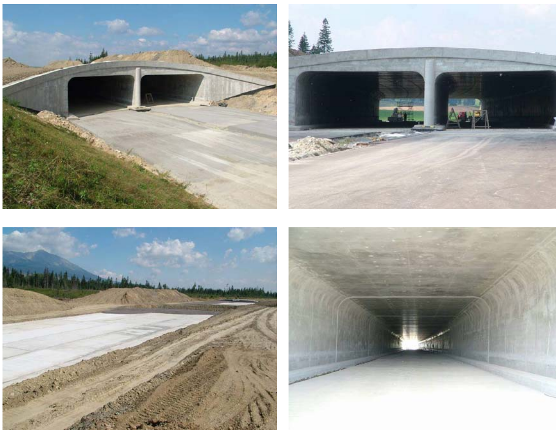
Obr. 8: Ekologický tunel na dálnici D1 v úseku Važec - Mengusovce: fotografie z výstavby [9]
