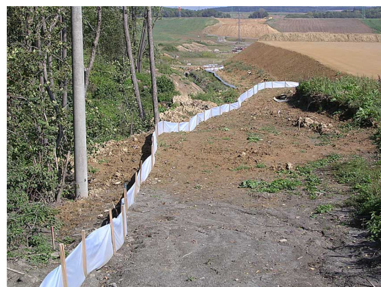
Obr. 4: Naváděcí pásy k usměrnění migrace obojživelníků podél drobných vodotečí. Vlevo provizorní zatrubnění vodoteče s jednou mokrou a dvěma suchými cestami (stavba D4704)
