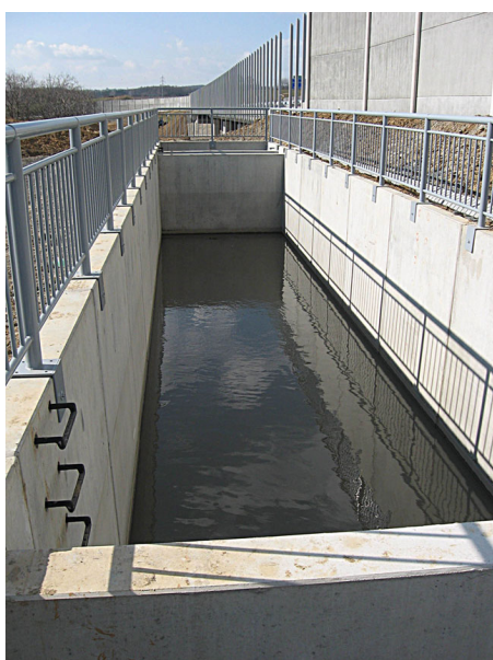
Obr. 8: Retenční nádrž bez postranní rampy, do které napadaly ropuchy obecné, ropuchy zelené a skokani hnědí (D4707)
