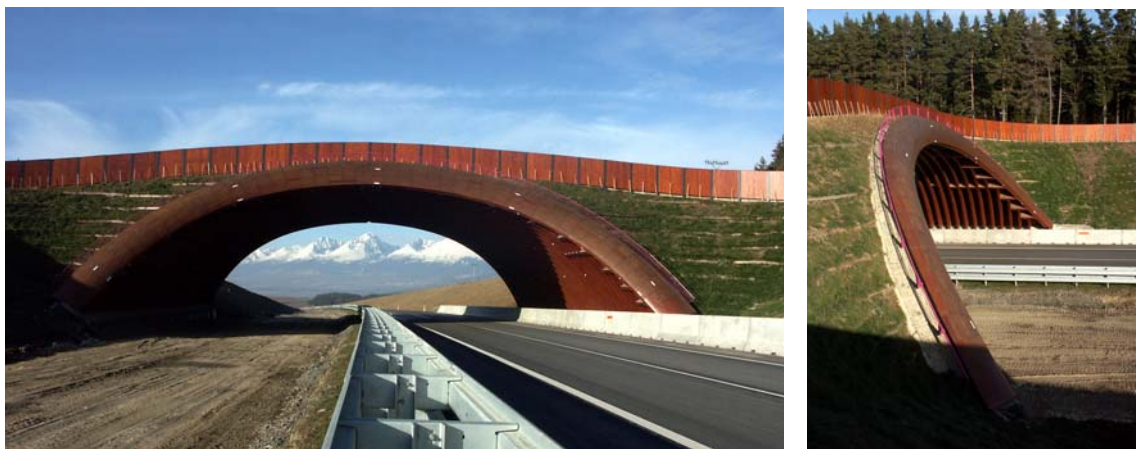
Obr. 2: Ekologický most na dálnici D1 v úseku Mengusovce - Jánovce (foto autor)
