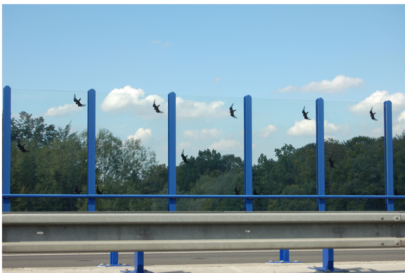
Obr. 1: Příklad nevhodné instalace čirých PHS se siluetami dravců na mostní konstrukci
