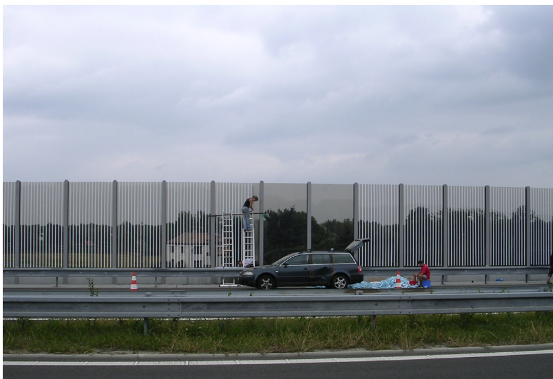
Obr. 2: Instalace pásků na PHS stavba D4709.1
