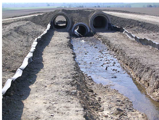
Obr. 4: Naváděcí pásy k usměrnění migrace obojživelníků podél drobných vodotečí. Vlevo provizorní zatrubnění vodoteče s jednou mokrou a dvěma suchými cestami (stavba D4704)
