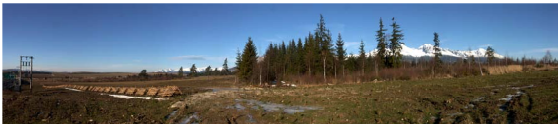
Obr. 10: Ekologický tunel na dálnici D1 v úseku Važec - Mengusovce: panoramatický pohled přístupu na straně Vysokých Tater (foto autor)
