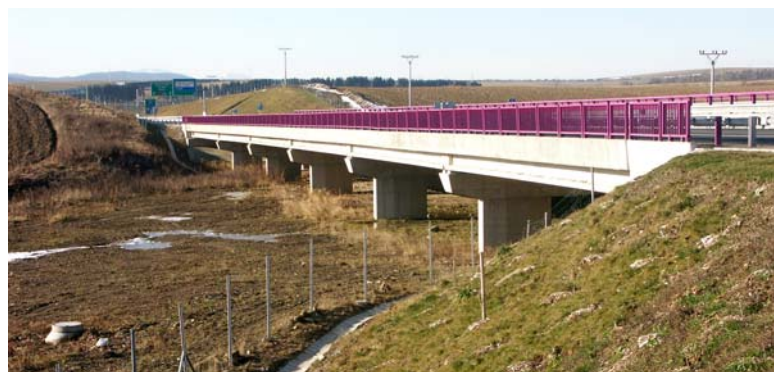
Obr. 13: Estakáda před ekologickým tunelem (foto autor)
