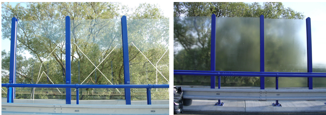
Obr. 3: PHS na mostní estakádě- obchvat Českého Těšína
