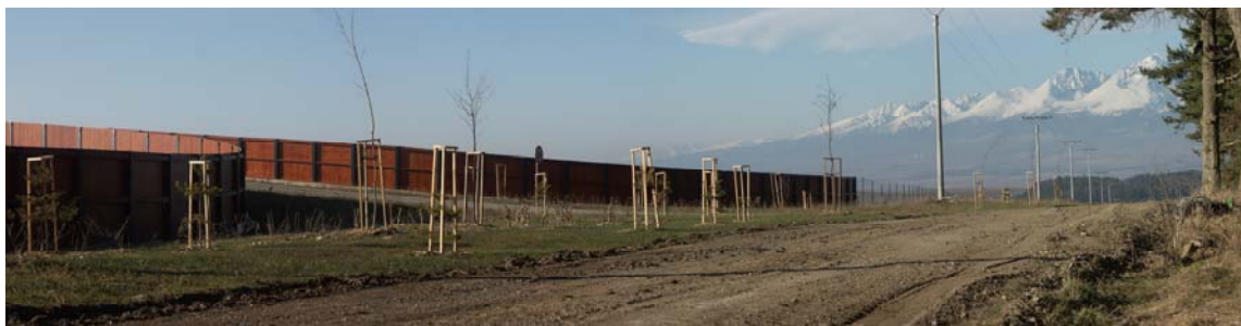
Obr. 4: Ekologický most na dálnici D1 v úseku Mengusovce - Jánovce: panoramatický pohled na vegetační úpravu strany sousedící s přilehlým lesním porostem (foto autor)
