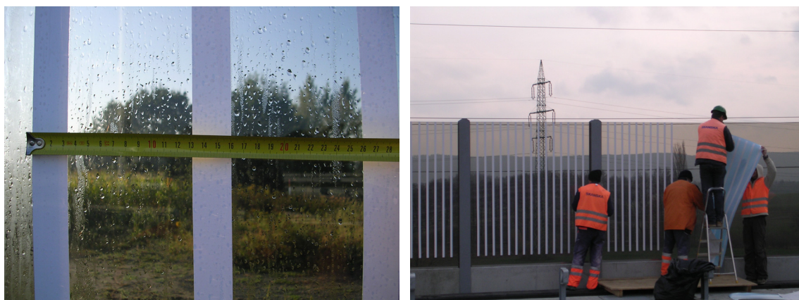
Obr. 4: Instalace pásků na PHS – stavba D4704
