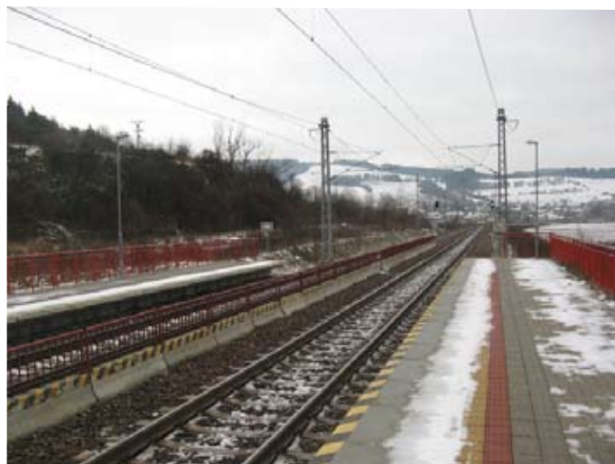
Foto 10 Oplatenie železnice výrazne znižuje funkčnosť migračného koridoru.
