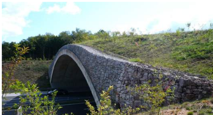
Stodvacet metrů široký ekodukt „Ivačevo Brdo“ v Chorvatsku je příkladem skloubení požadavků ochránců přírody a stavařů.
